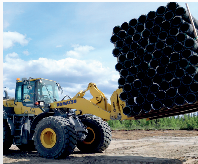
Voici comment on a transporté le grand nombre de conduites Advanced Enviro))Septic nécessaires pour ce projet
