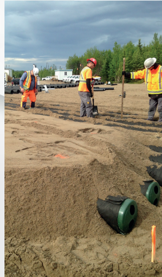
Recouvrir les conduites Advanced Enviro))Septic avec du sable filtrant
