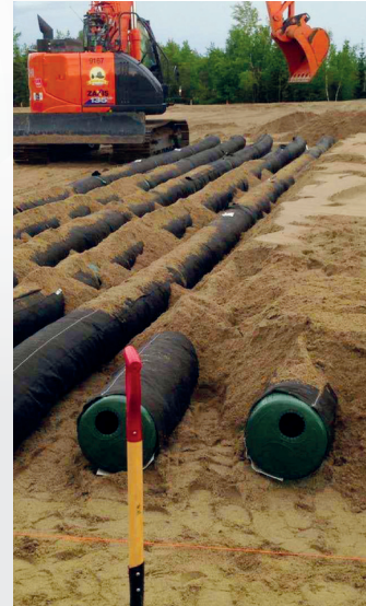
Recouvrir les conduites Advanced Enviro))Septic avec du sable filtrant
