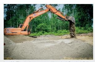
Le sable filtrant est un composant important d'une installation System O))
